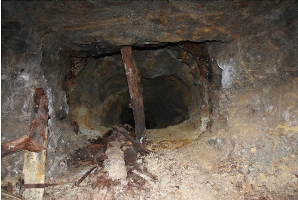
Slika 2.64 – Objekt 19f – vpadnik, levo lesene stopnice, po sredini lesena okroglica kot podpornik (avgust 2016)
