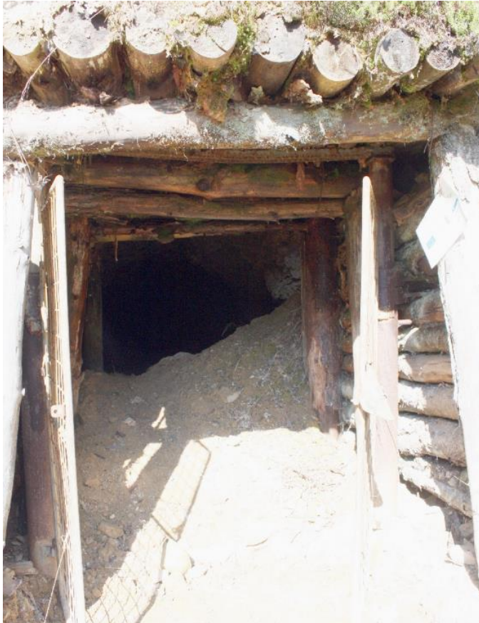
Slika 2.14 – Lesen vhod v Izvozni rov-2. lesena odstavka (avgust 2016)
