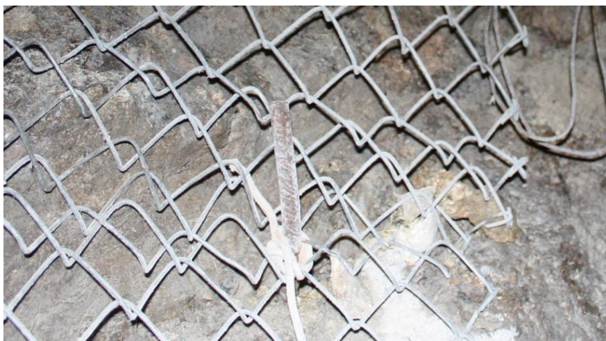
Slika 3.3 – Pritrjevanje mreže s sidrom \Phi 10
