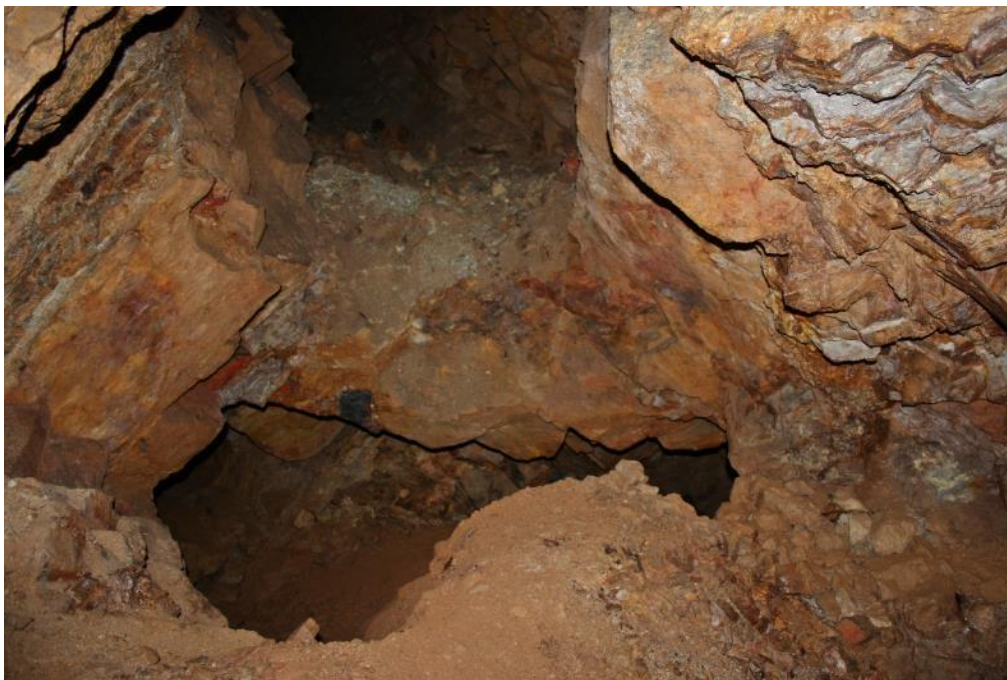
Slika 2.26 – Objekt 4c-zgoraj proga proti S, spodaj zrušek tal v vpadnik (avgust 2016)
