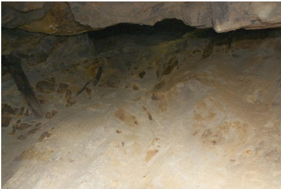
Slika 2.63 – Objekt 19e – nadkop, levo lesena podpora (avgust 2016)
