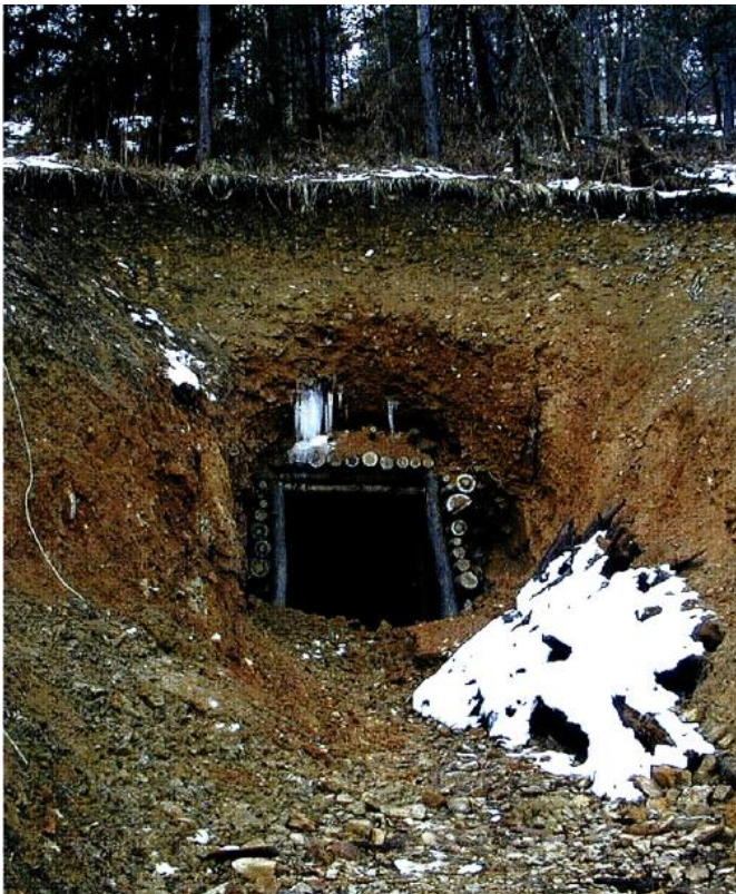
Slika 2.11 – Vhod v Izvozni rov po prestavitvi v notranjost (foto: Blaž Zarnik, vir: Rudnik Sitarjevec, Ivan Godec, maj 2010)
