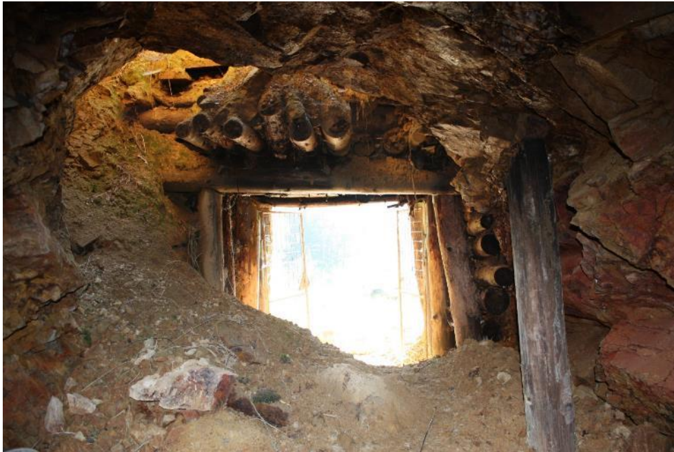
Slika 2.16 – Zrušen material z odprtino nad vhodnim delom (avgust 2016)
