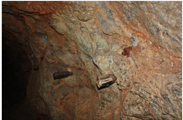
Slika 2.21 – Leseni nosilci za vode ali cevi, proga proti križišču 5 (avgust 2016)
