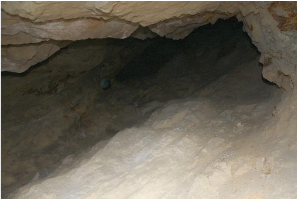
Slika 2.61 – Objekt 19c – nadkop (avgust 2016)
