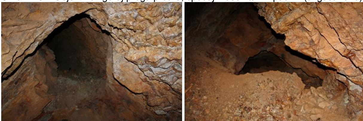
Slika 2.27 – Objekt 4c-levo proga proti S, desno zrušek tal v vpadnik (avgust 2016)
