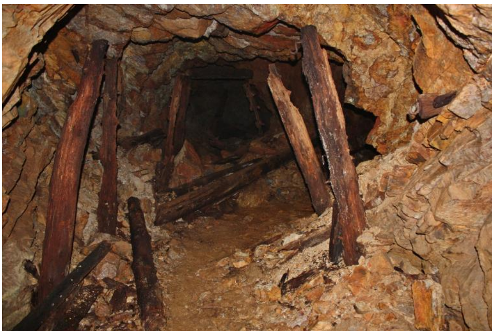
Slika 2.29 – Objekt 6 – pogled v progo 6a od objekta 5 proti 6e (avgust 2016)
