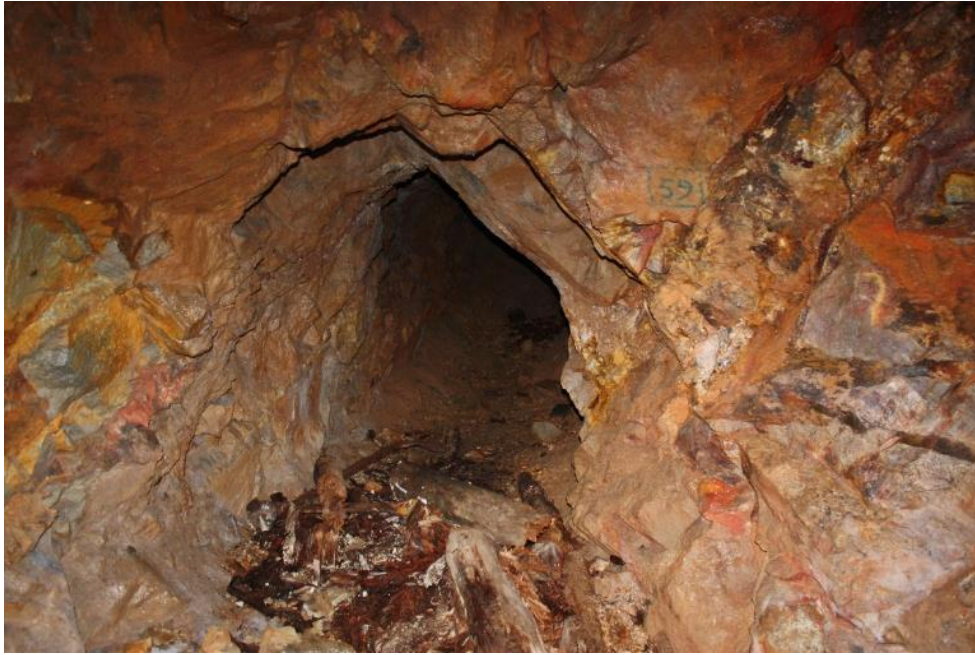
Slika 2.37 – Objekt 8b – proga proti JV (avgust 2016)
