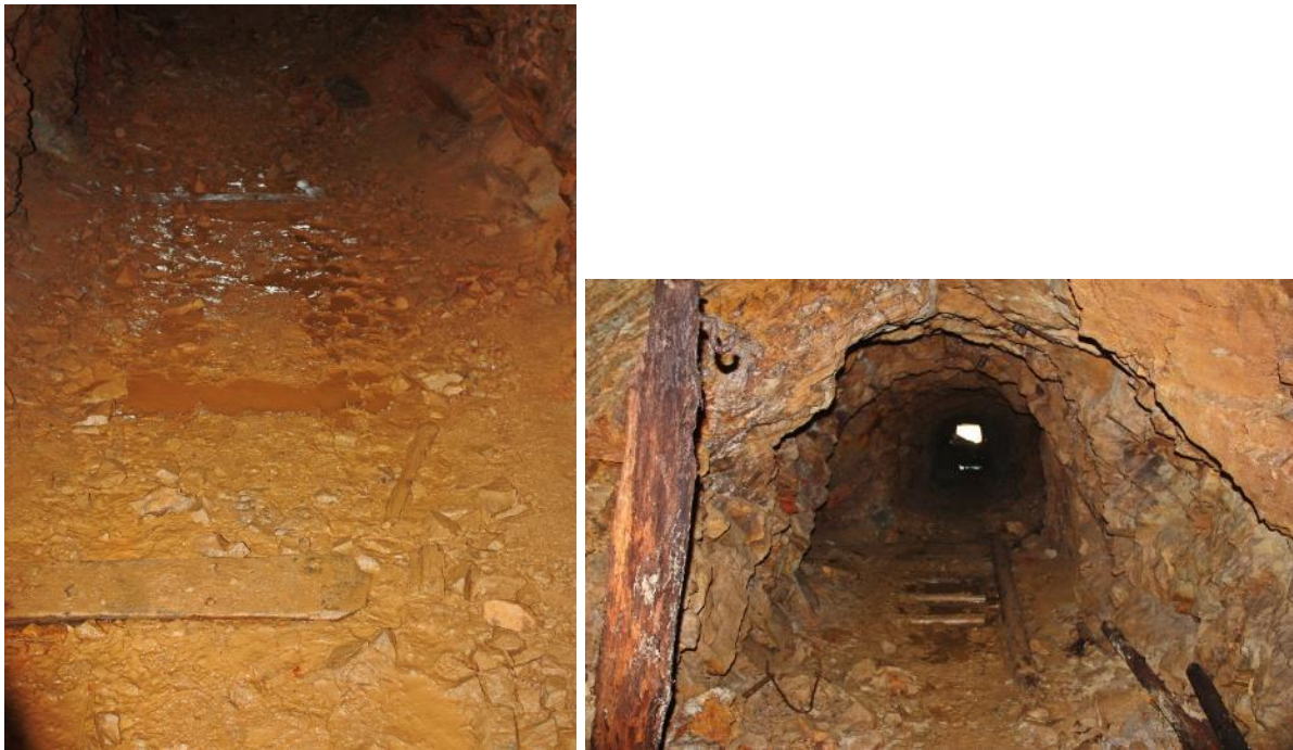
Slika 2.18 – Mokra in zablata tla v izvoznem rovu, druga fotografija-pogled od križišča 5 proti vhodu 1 (avgust 2016)
