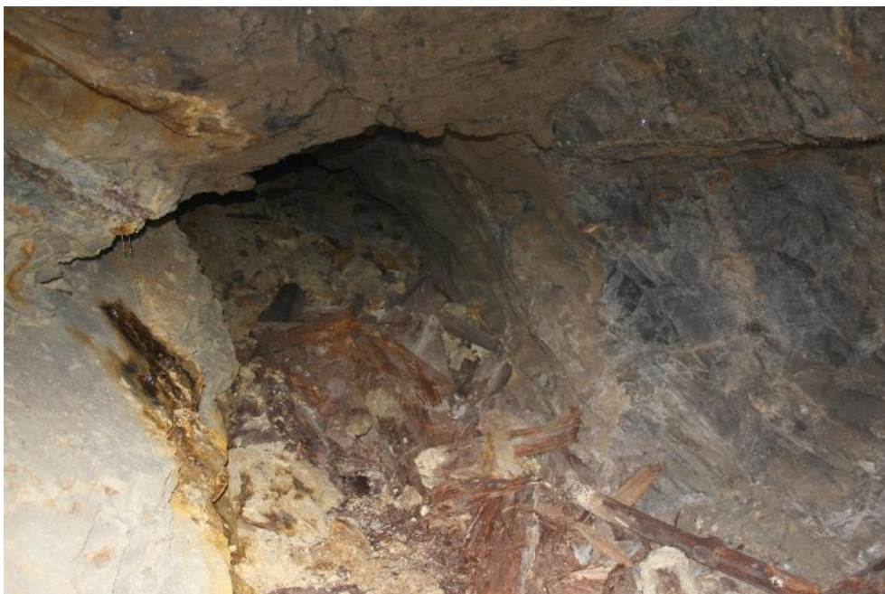
Slika 2.65 – Objekt 19g – proga proti zahodu – delno zarušena (avgust 2016)
