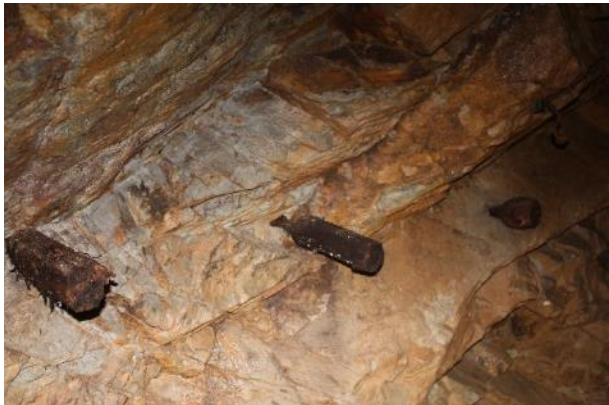
Slika 2.21 – Leseni nosilci za vode ali cevi, proga proti križišču 5 (avgust 2016)
