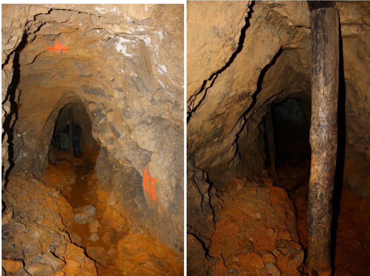
Slika 2.80 – Pogled v nadkop od zgoraj navzdol (avgust 2016)
