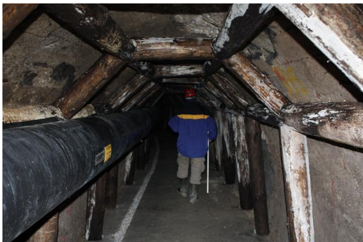
Slika 4.12 – Šestkotna lesena podgradnja (vir: SIIPS AD)
